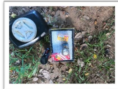
CAMBIO DE FILTROS Y BUJIAS
